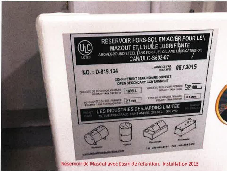
Réservoir de Masout avec bassin de rétention. Installation 2015
